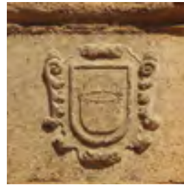
14. Calderí de travertí. Façana Església St. Esteve
